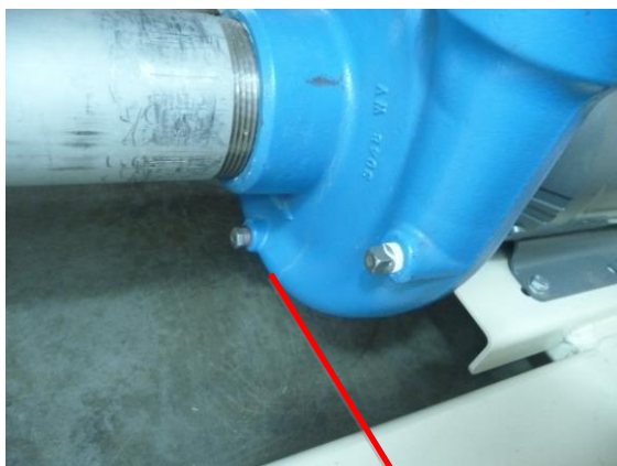
Bouchon de vidange sur le corps de la pompe
