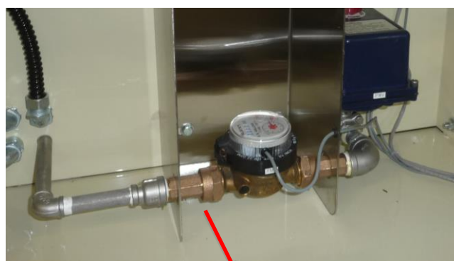
Ouvrir les raccords sur le débitmètre de purge pour vidanger l'eau
